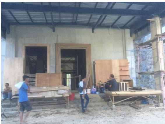
Gambar 20 Foto aktivitas pembangunan gedung hall baru TVLC
