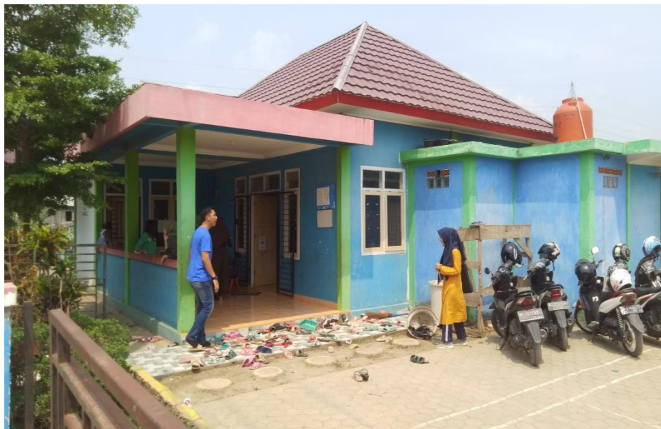
(Tampak depan bangunan yang digunakan untuk proses pembelajaran RBC)
