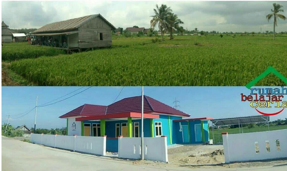
Gambar 6. Bangunan Gedung Baru Tempat Melaksanakan Program Pendidikan RBC
