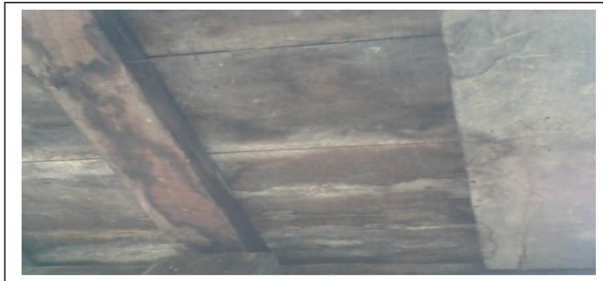
Gambar: *Konstruksi lantai yang dengan kerangka kasau.*
