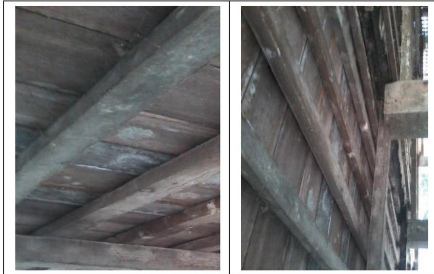
Gambar: *Konstruksi lantai yang dengan kerangka kasau.*
