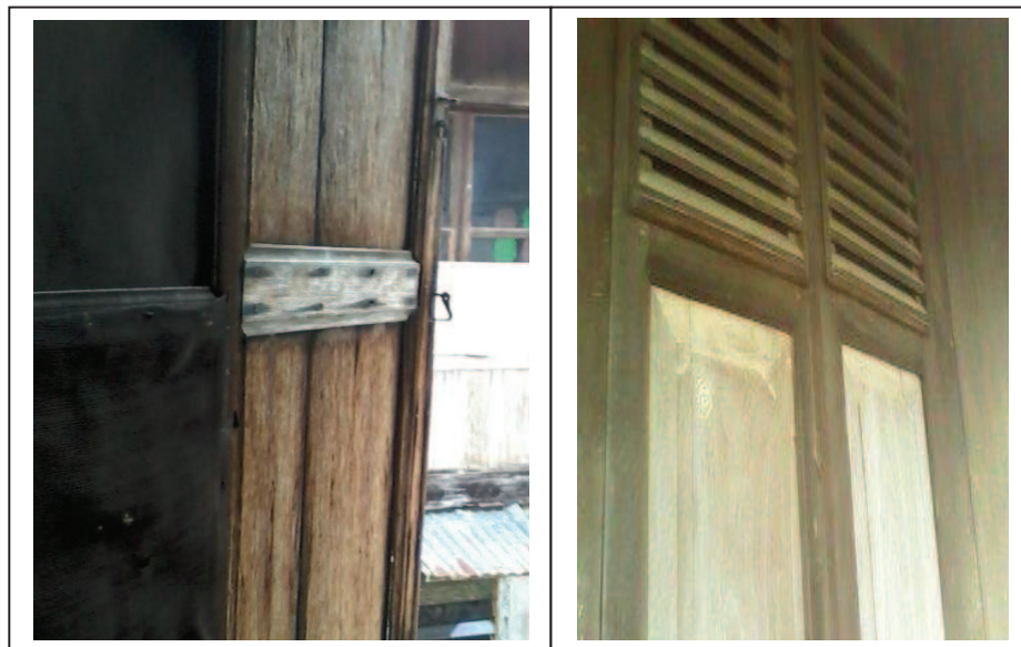
Gambar 1: Bagian konstruksi rumah limas, terdapat sebuah dua daun jendela ( Sumber: Data Lapangan, Penulis )
