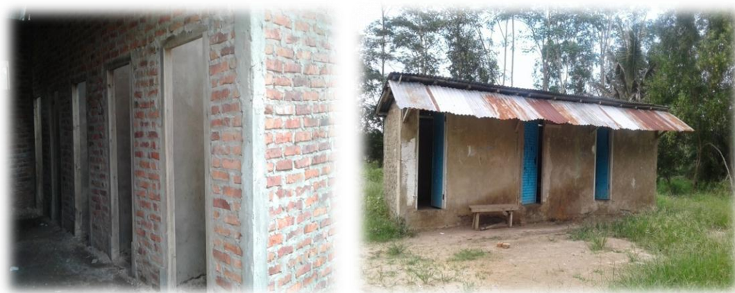
Gambar 5. WC dalam Tahap Pembangunan dan Renovasi
