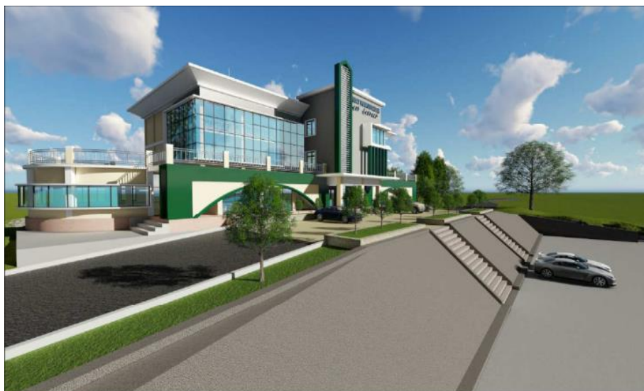
Gambar 3.3: Tampak samping Pusat Perpustakaan IAIN Curup
