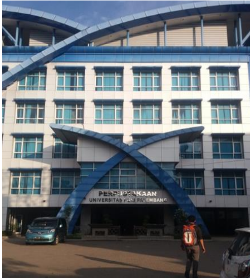
Gedung UPT Perpustakaan PGRI Palembang
