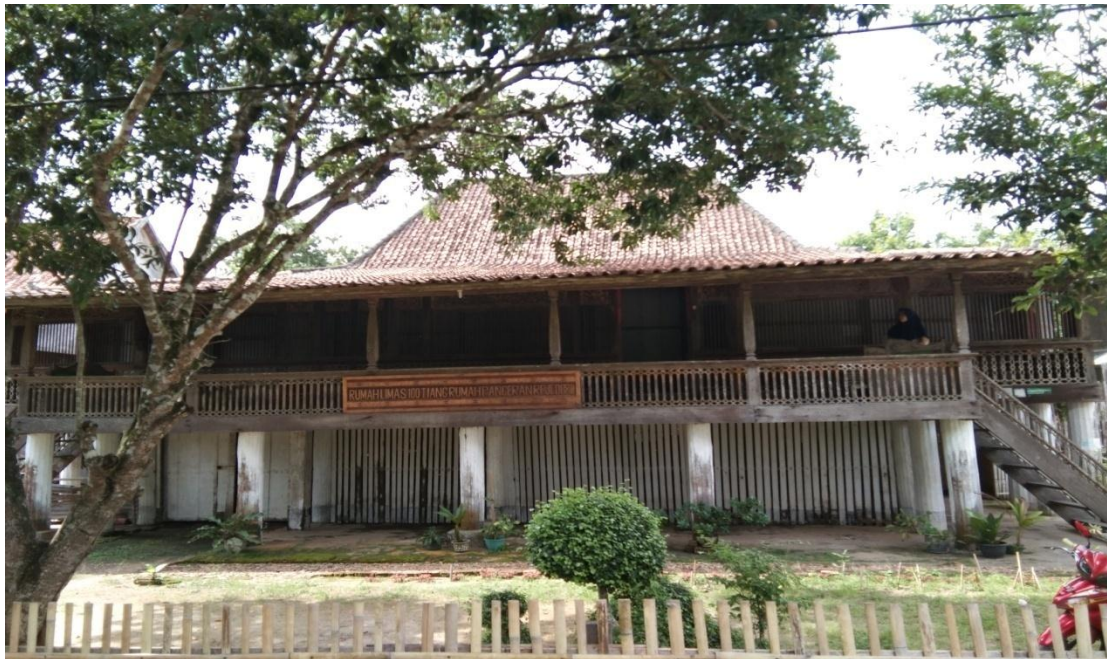
Gambar 1 dan 2 Tampak depan Rumah Limas 100 Tiang.
