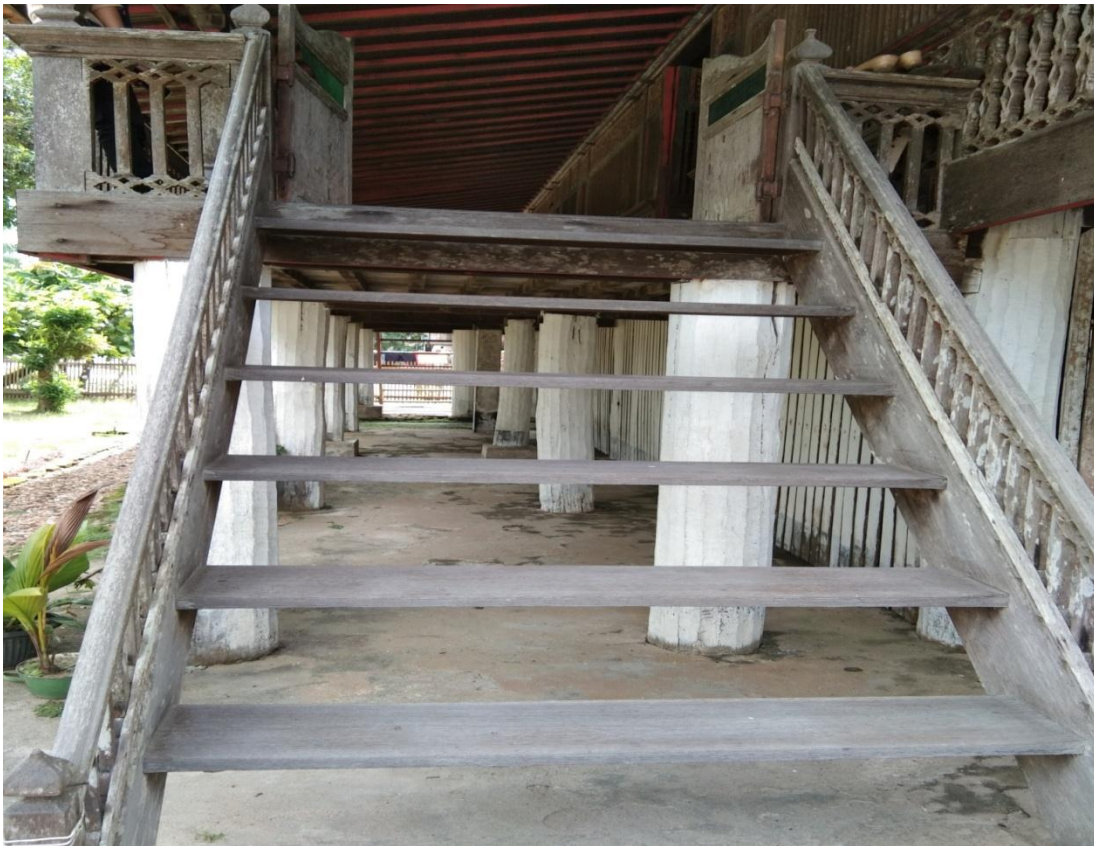
Gambar: 3. 4 (Tampak Depan dan Tangga Rumah Limas )
