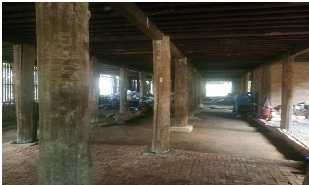
Gambar 17-18 “Tiang dalam dan Tiang Penyangga Rumah Limas 100 Tiang”
