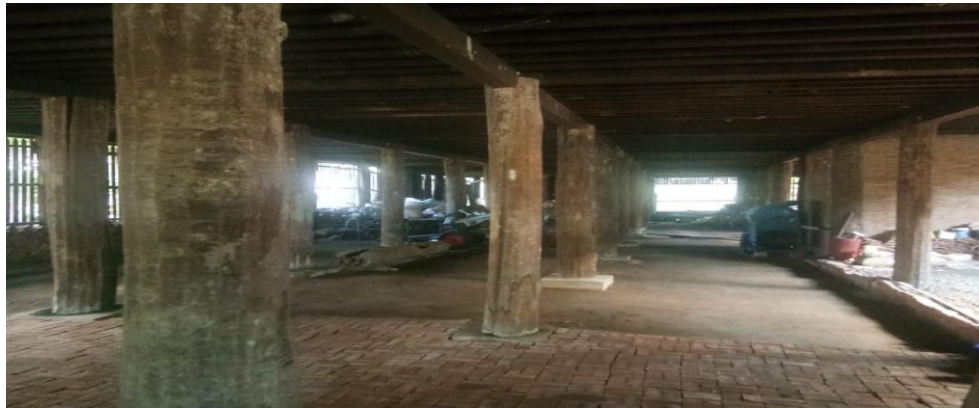
Gambar: 3.1 (Tiang Penyangga Rumah Limas 100 Tiang, Bagian Bawah rumah dan Garang Rumah)
