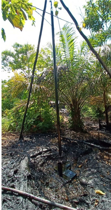
Gambar 4. Derrick dan Pipa Mata Bor 63
