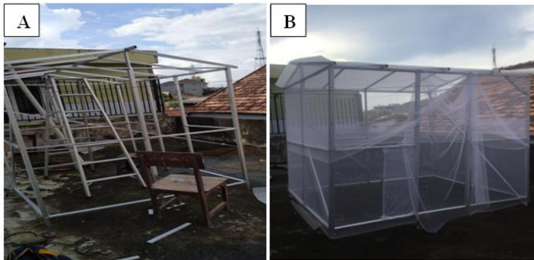
Gambar 1. Pembuatan sungkup, (A) Kerangka sungkup dan (B) Sungkup yang sudah jadi.
