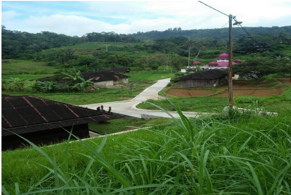
Gambar 4.2 Pembangunan Jalan ke Surau Gadang di Jorong Cubadak Lilin.
