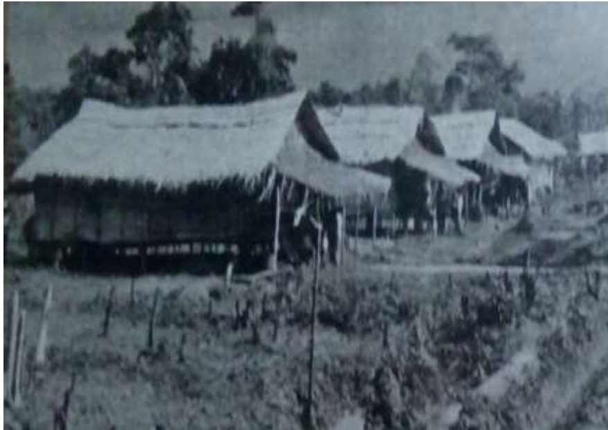
Gambar 12: Bentuk Rumah Sederhana Kolonis di Belitang yang Digunakan untuk Tempat Perlindungan dari Terik Matahari dan Hujan Sumber: Kantor Dinas Kearsipan Kecamatan Belitang, Kabupaten OKU Timur
