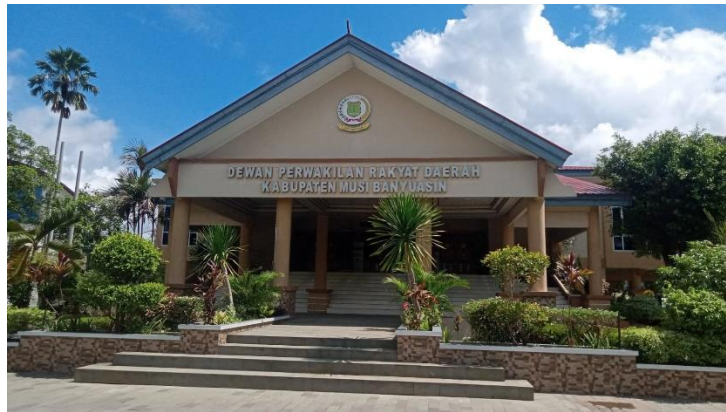
Gambar III.4 : Gedung Sekretariat DPRD Kabupaten Musi Banyuasin (Sumber : Dokumentasi Pribadi (Senin, 13 Desember 2021, pukul 10.48 WIB))
