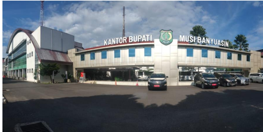
Gambar III.2 : Gedung Sekretariat Kabupaten Musi Banyuasin (Sumber : Dokumentasi Pribadi (Senin, 13 Desember 2021, pukul 16.01 WIB))
