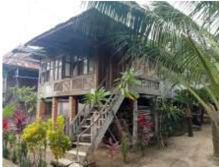
Penampakan tanah beserta bangunan rumah di atasnya pada bagian kiri
