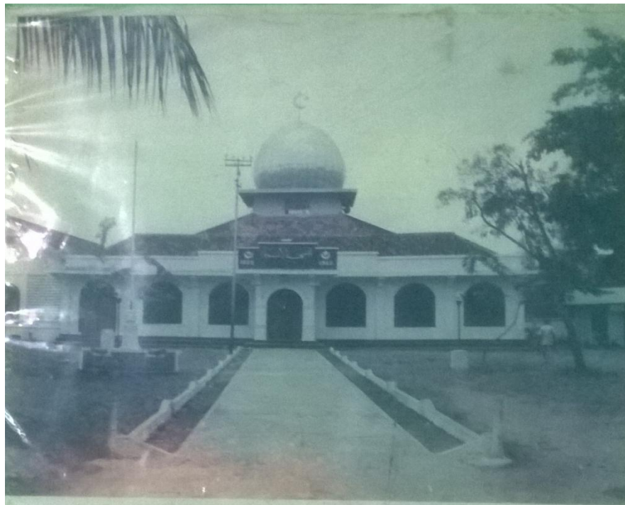
Gambar 2.1: Gambar Masjid Jami' Al Anwar sebelum renovasi yang berbentuk Semi kubah, yaitu perpaduan antara Limas dan Kubah
