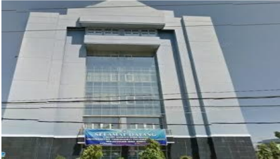
Gambar 1 Gedung Perpustakaan Universitas Tridianti Palembang
