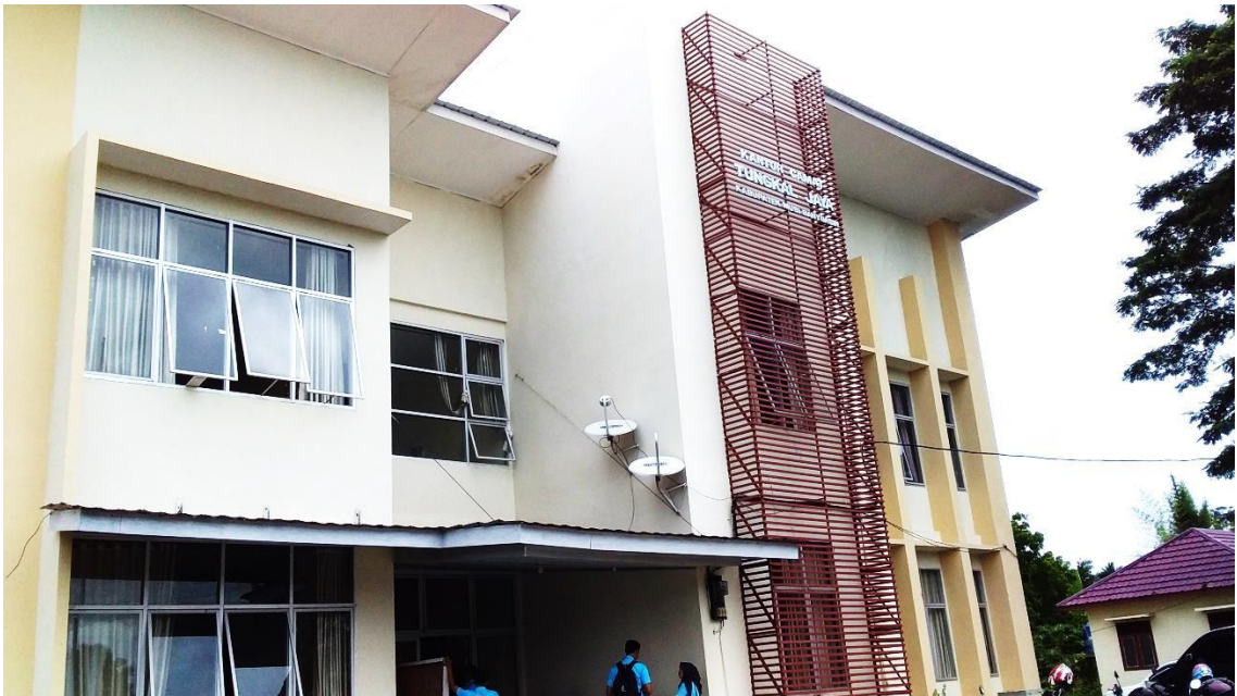
Gambar 1. Kantor Camat Tungkal Jaya, tampak dari depan dan dari samping
