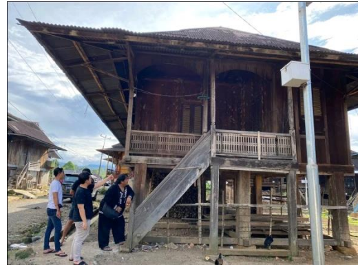
Rumah Baghi Pagaram
