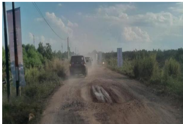
Gambar 1.1 Kondisi jalan menuju Desa Sungsang IV
