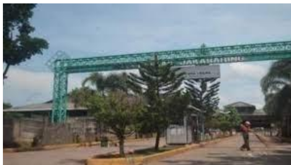
Gambar 2. Pasar Induk Jakabaring Kota Palembang Sumber (Dokumentasi pribadi)
