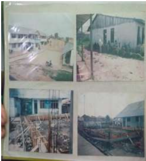
Dokumentasi, Pembangunan Gedung-gedung Sekolah Pada Tahun 1992
