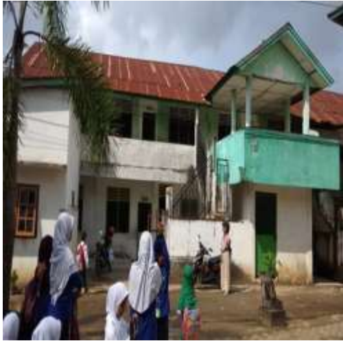
Dokumentasi, Bagian Depan Gedung Sekolah MI Assanadiyah Al-Islamiyah
