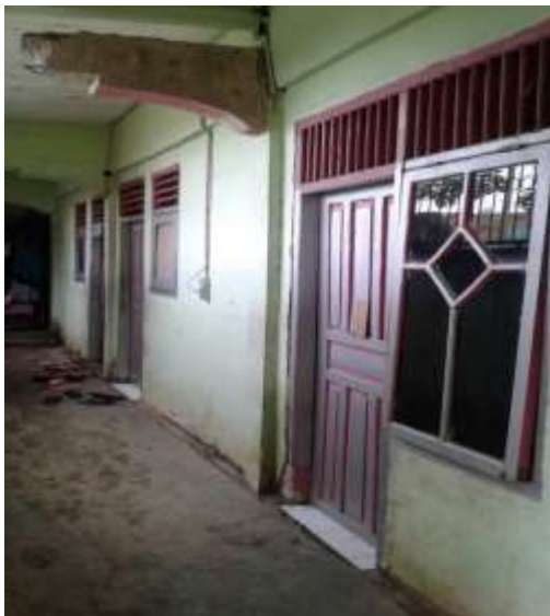
Dokumentasi, Keadaan Unit Asrama Perempuan Di Assanadiyah Al-Islamiyah
