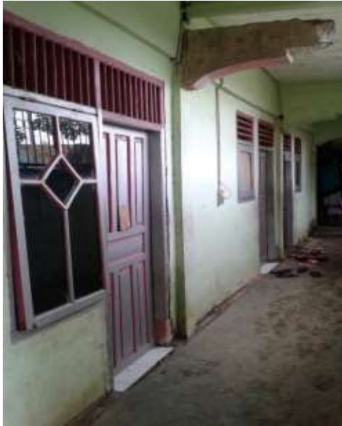
Dokumentasi, Keadaan Unit Asrama Laki-laki Di Assanadiyah Al-Islamiyah
