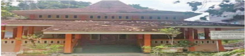
RUSAK: Tampak kondisi Museum Si Pahit Lidah yang rusak. -foto: berry/sumeks-
