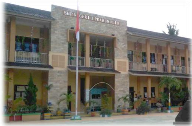
Gedung SMP Negeri 1 Prabumulih
