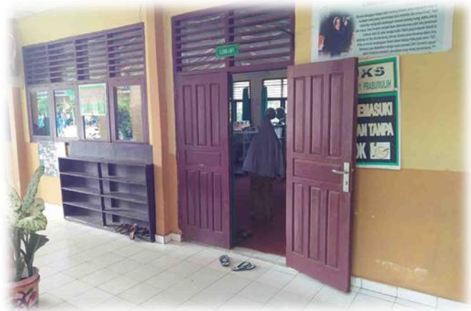
Gedung Perpustakaan SMP Negeri 1 Prabumulih
