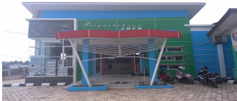
Gedung Layanan Sirkulasi di Tempat Baru
