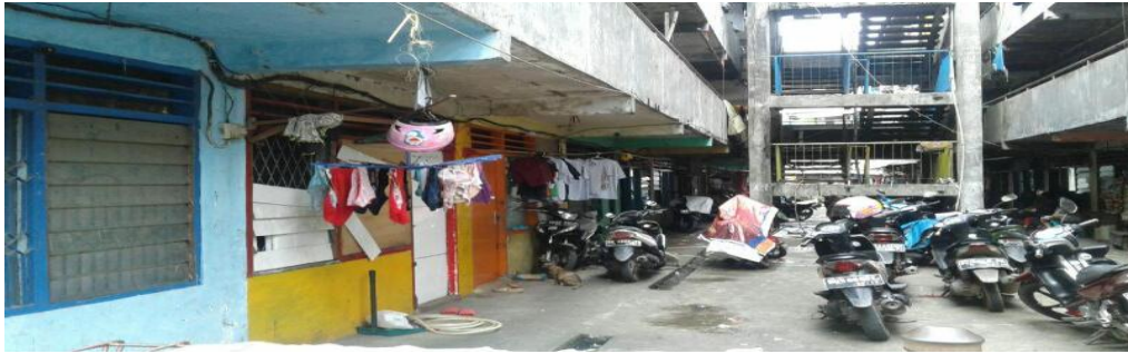
Gambar. 10 Kondisi Lingkungan Rumah Susun Blok 13
