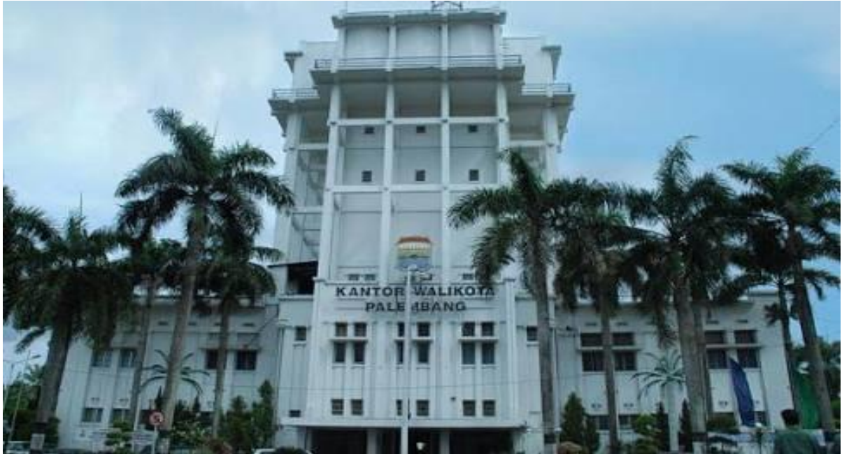
Gedung Kantor Walikota (Pemerintah Kota Palembang)
