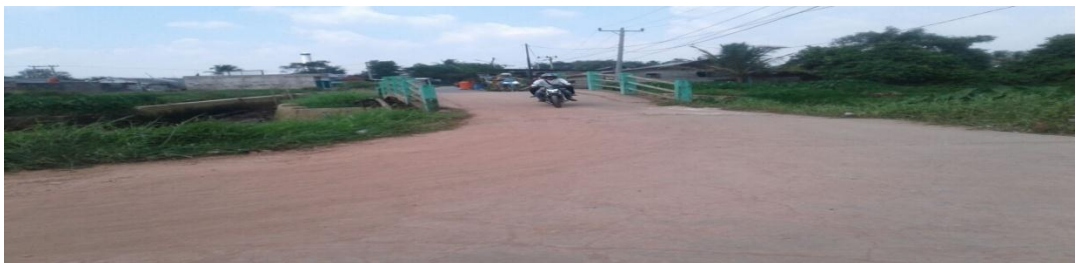
Gambar 5: Jembatan akses ke pondok pesantren
