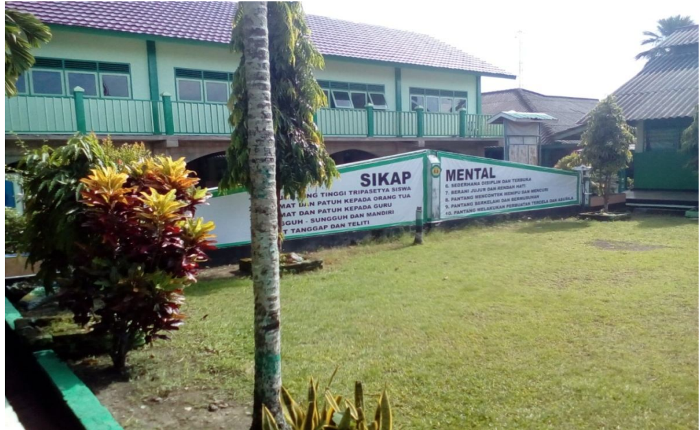
Gambar III : SMA YKPP tampak dari belakang
