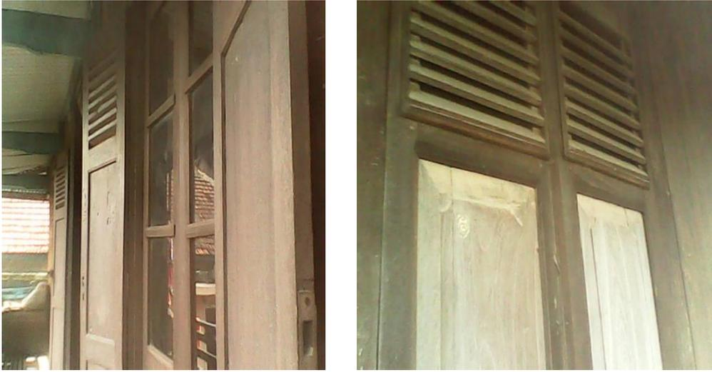
Gambar III: Pintu dan jendela yang menggunakan sistem lubang (puting) tidak menggunakan paku dan engsel.
