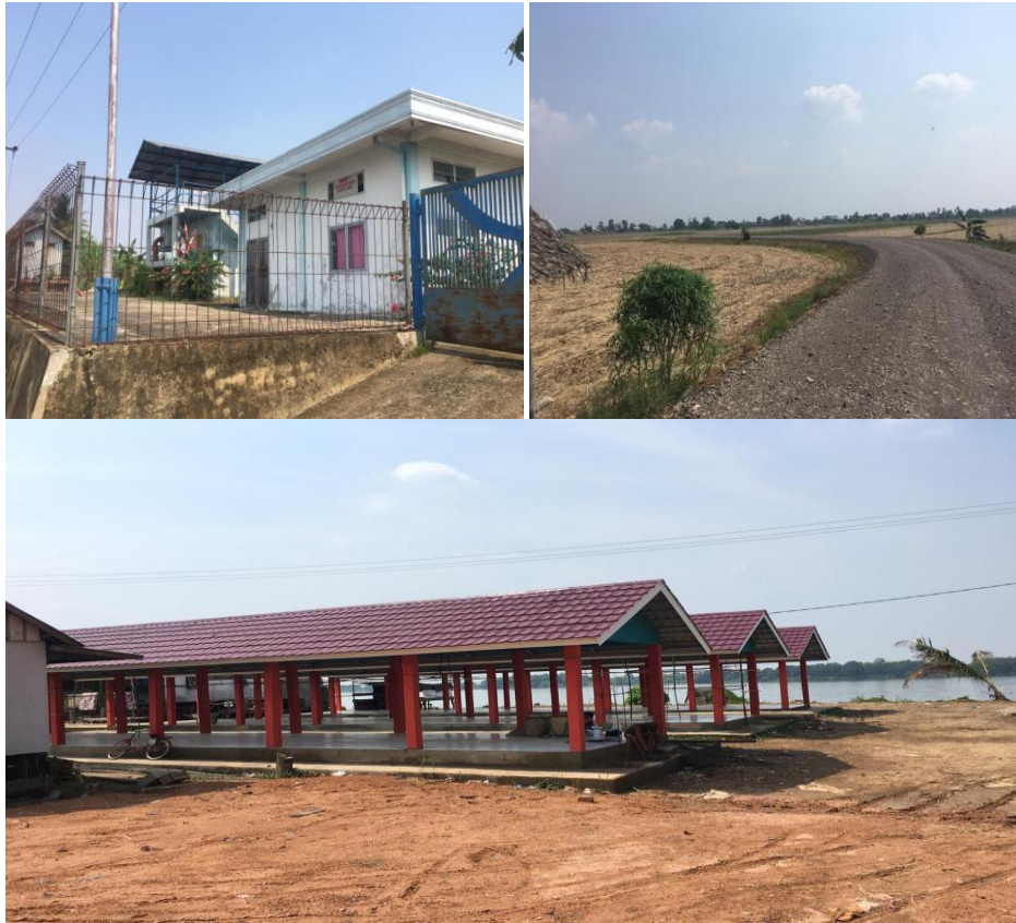
Gambar 3.6 Pembangunan Yang Berlangsung di Desa Arisan Musi Timur
