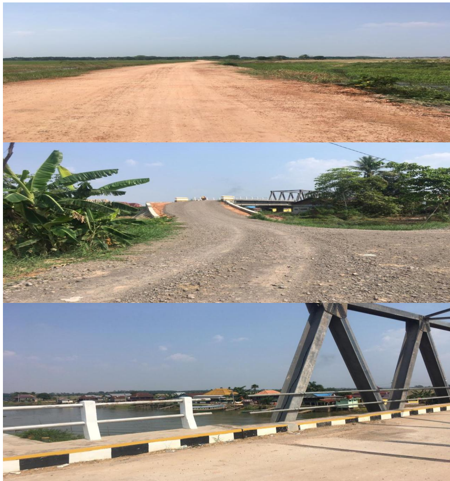
Gambar 3.3 Jalan Penghubung Antar Desa
