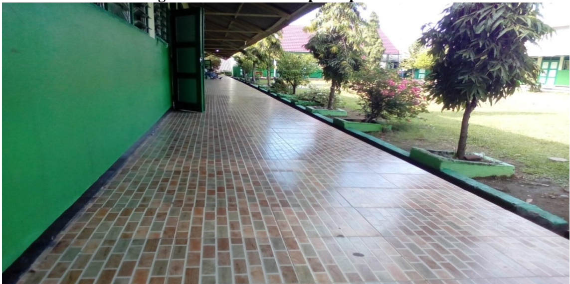
Gambar VI : Teras ruang kelas SMA YKPP tampak dari Timur
